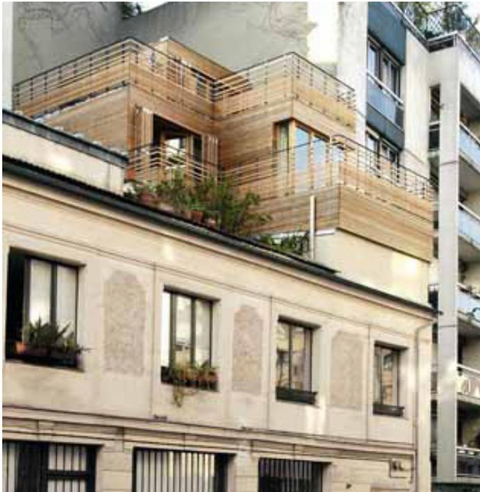
Figure 4: Exemple d'une surélévation en ossature bois d'un immeuble à Paris, Maître d'oeuvres : Edouard Boucher, Eric Pouget & Associés
