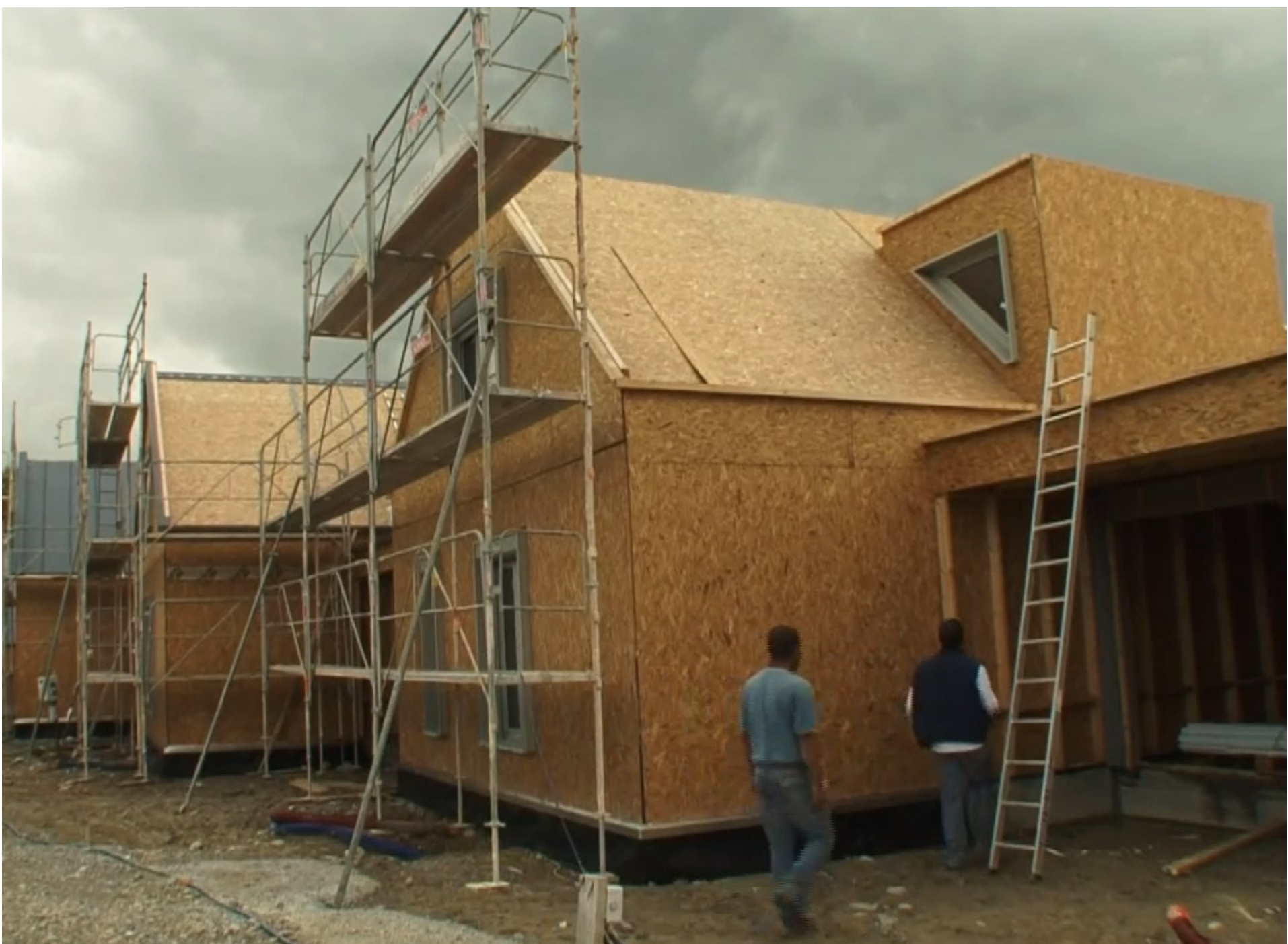
Figure 5. Assemblage sur le chantier des panneaux préfabriqués
