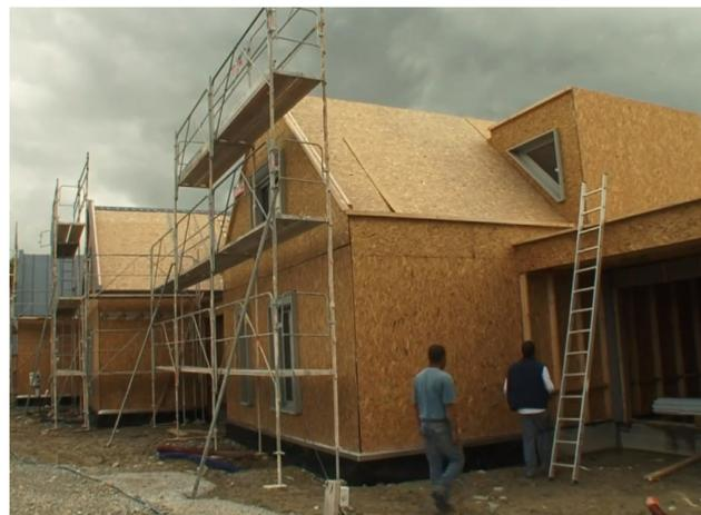
Figure 3. Assemblage sur le chantier des panneaux préfabriqués
